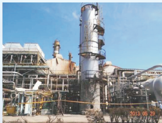
高雄某煉油廠管線洩漏爆炸造成製程單元損毀圖
