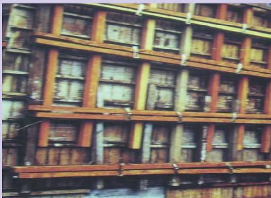
以板料、角材、縱格柵及橫格柵，四層模板組立方式，上下端連結牢固預防倒塌危害。
