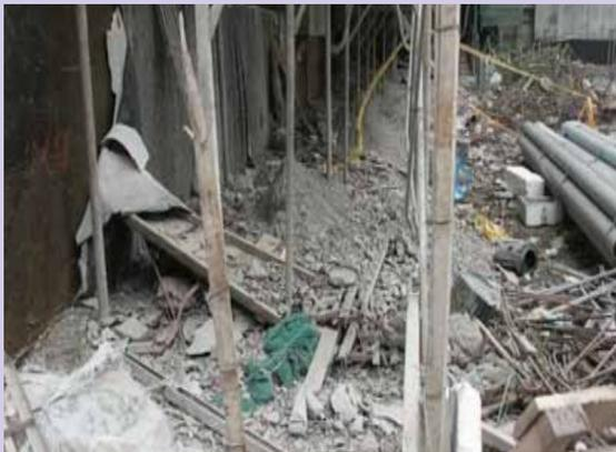
施工架基礎地面未平整及地質鬆軟，支柱易有倒塌崩塌之危害。
