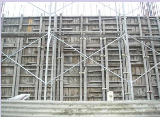
縱格柵腐損斷裂，橫格柵並未貫穿模板(未按圖施工或未經專人妥為設計)。
