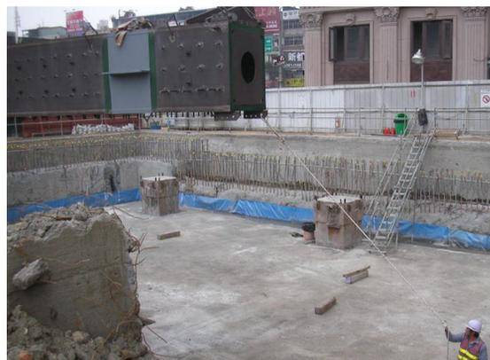
吊掛作業時應禁止人員進入吊物下方，吊運路線大型物體可使用牽引繩協助，避免物體碰撞及飛落。
