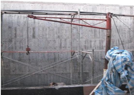
起重機具未標示最高負荷，勞工使用時可能超過負荷，造成物體飛落之危害。
