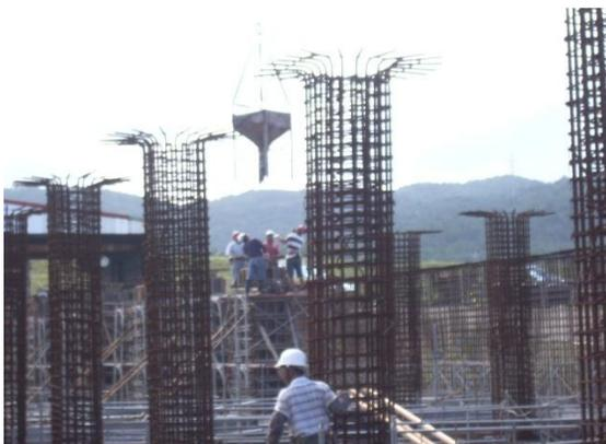
吊掛作業時人員站立於吊舉物下協助作業，易有物體飛落肇災之危害。
